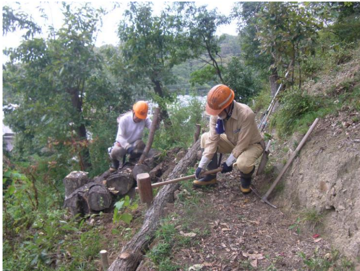
園路維持補修状況
