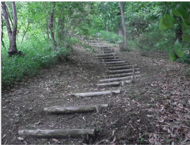
甲南女子大学ふれあいの森 園路階段整備 令和6年 5月
