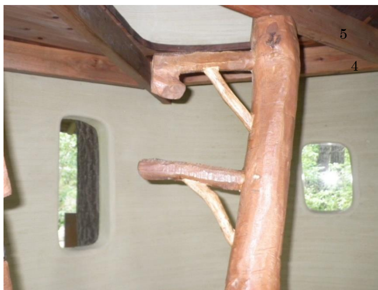
甲南女子大学ふれあいの森 ツリーハウス屋内梯子段補修 令和6年6月
