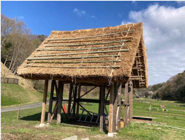
あいな里山公園 開園 10 周年記念オブジェ 屋根養生シート除去状況 令和 8 年 4 月 5 日
